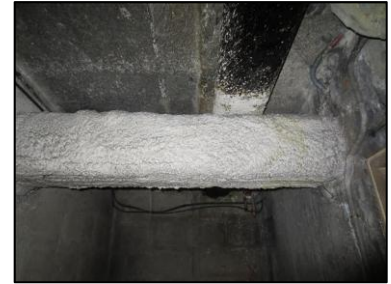
Photo N° 929 AMIANTE CIMENT -- COULOIRS -1 Gaines & coffres horizontaux Ventilation haute (Fibres-ciment)
