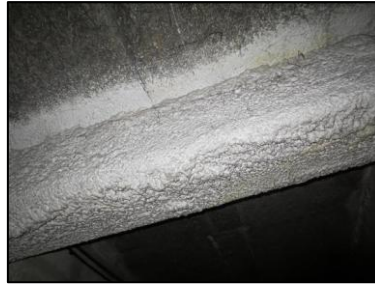
Photo N° 928 AMIANTE CIMENT -- COULOIRS DE CAVES
